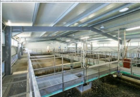
ROZŠÍŘENÍ KANALIZACE A ČOV, ZDIBY
