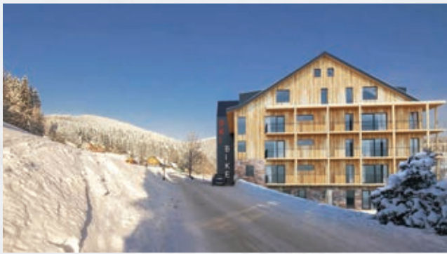
REKONSTRUKCE A DOSTAVBA UBYTOVACÍHO ZAŘÍZENÍ, JANSKÉ LÁZNĚ
