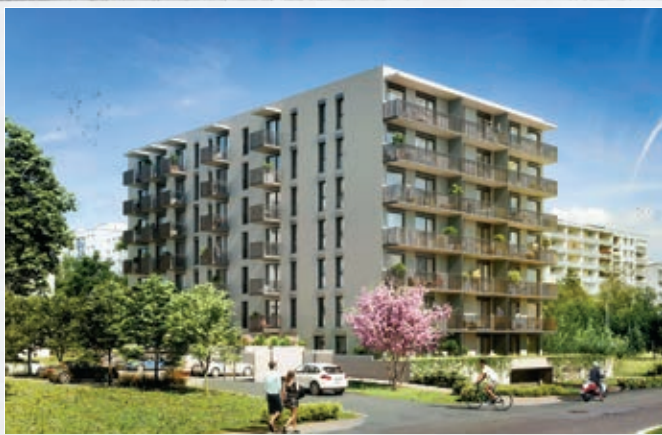
BYTOVÝ DŮM JURKOVIČOVA, PRAHA
