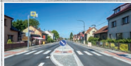
I/35 OPRAVA SILNICE, OSTROMĚŘ
