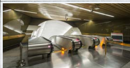
MODERNIZACE POHYBLIVÝCH SCHODŮ, PRAHA
