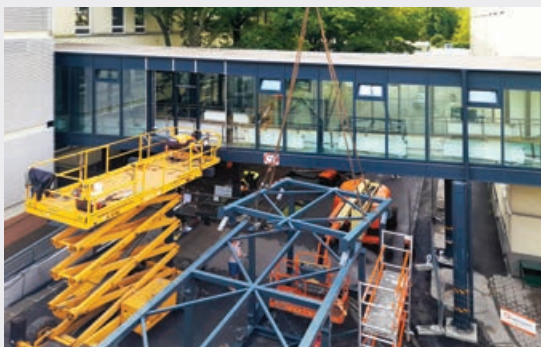
Výstavba objektu s hyperbarickou komorou v Městské nemocnici Ostrava
