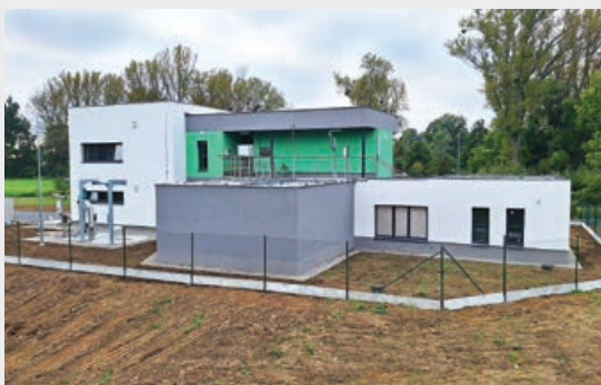
Odkanalizování a ČOV Petřvald
