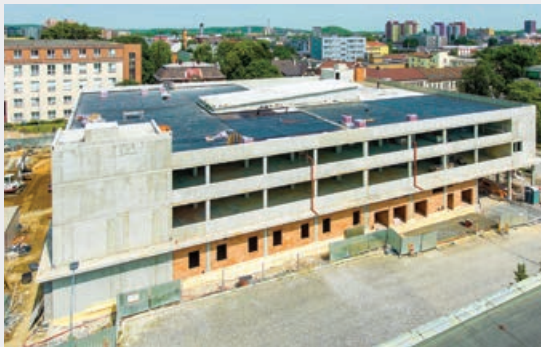
Multifunkční parkovací dům u Městské nemocnice Ostrava
